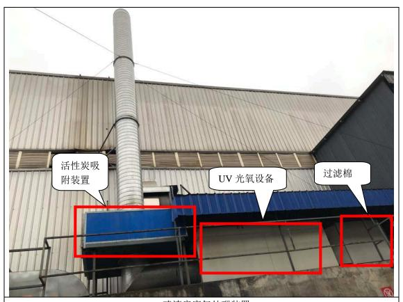
4#喷漆房废气处理装置
