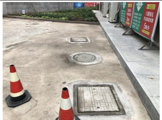
新增化粪池所在地
