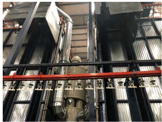
立式粉末固化进出口集气罩
